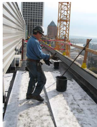
Membrane Install L24 – Nov. 2008
