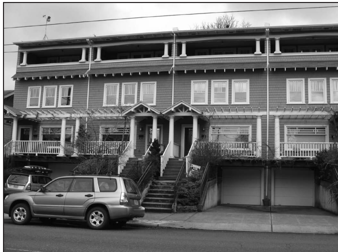
Se ha incorporado visibilidad natural en el diseño de estas townhouses mediante la creación de "ojos" en la fachada del edificio a manera de ventanas, porches y balcones.
