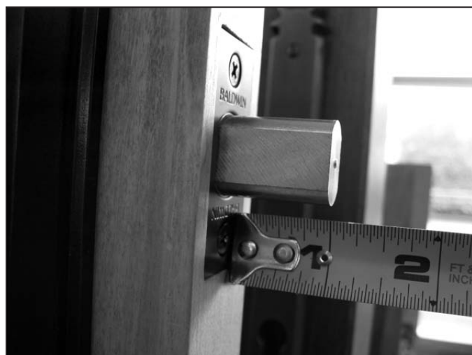
Las puertas que dan al exterior deben tener cerrojos de pestillo a manera de controlar el acceso. El pestillo debe medir una pulgada como mínimo, lo cual dificultará que se abra la puerta de una patada.
