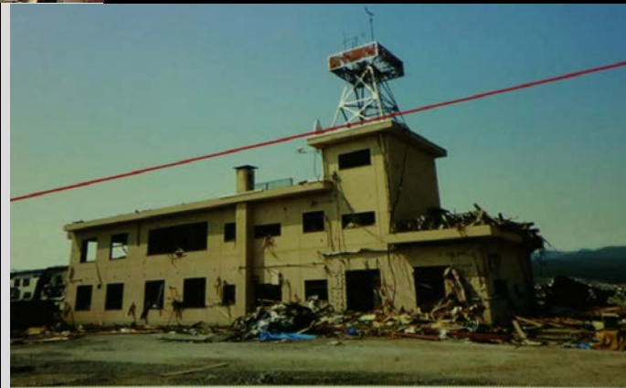
消防庁舎 (東側・4月13日)
